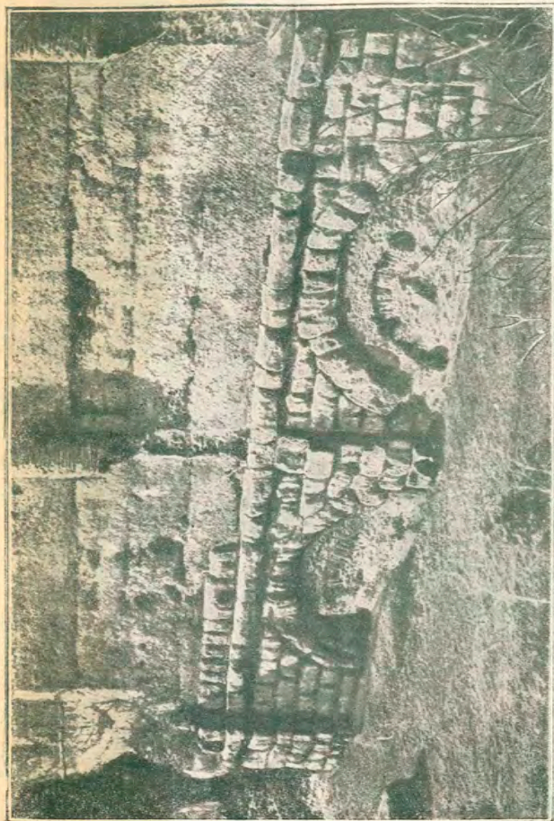
Оригинальная и репарационная (эпохи Августа) кладка стен Марсиева водопровода у Ponte Lupo (Деман, табл. XX, фото 1925 г.).
