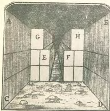
Канал самого древнего Аппиева водопровода (Aqua Appia), высеченный в скале, по расследованию Рафаэля Фабретти (De aquis et aquaeductibus veteris Romae. Roma, 1680, I, 38, 39, 40) (Деман, стр. 23; Fabretti).
