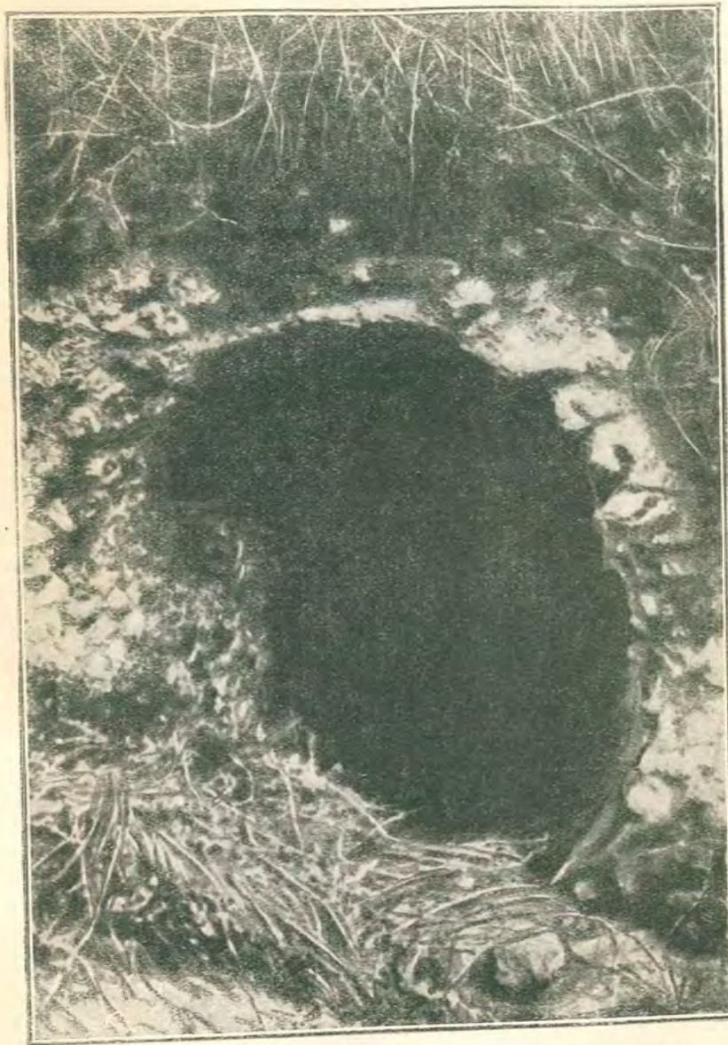
Подземный канал Марциева водопровода времен Августа (Деман, табл. XXIV, 2, фото 1925 г.).
