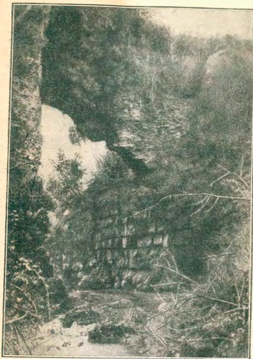
Часть староаниенского водопровода (Anio Vetus) так наз. Ponte Taulella. Явные следы восстановления от эпохи сооружения Марциева водопровода и эпохи Августа (Деман, табл. X, 1, фото 1925 г.).
