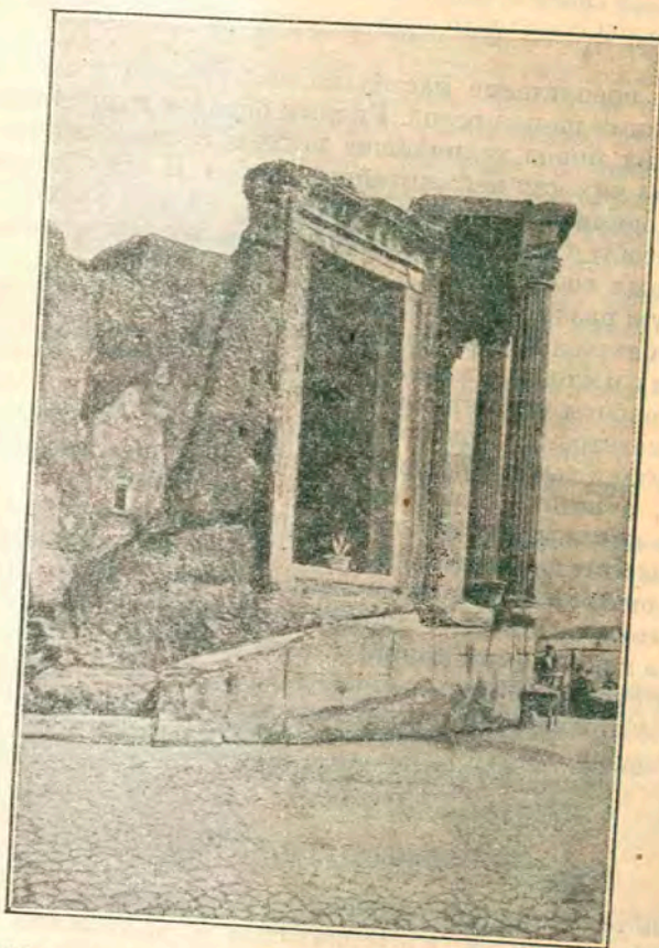
Образчик вольной, иррегулярной кладки. Круглый храм в Тиволи (по Моргану).
