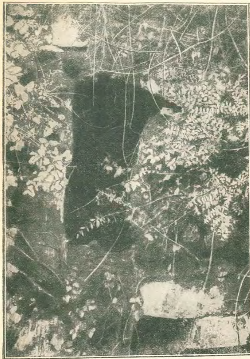
Староаниенский водопровод (Anio Vetus). Туннельная проходка сквозь холм Colle Cairolì. Нижняя часть проходки (Деман, табл. XI, 2, фото 1925 г.).
